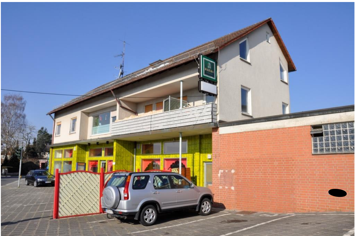
Ansicht von der Hauptstraße
